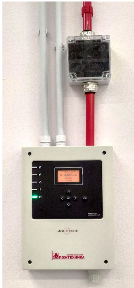
Рисунок 1 – Внешний вид извещателя с фильтром
